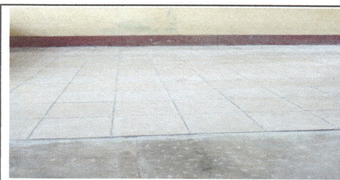
Foto 5: Se observa la colocación del piso
