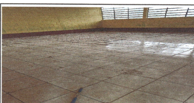
Foto 6: Se observa el piso de las aula terminados
