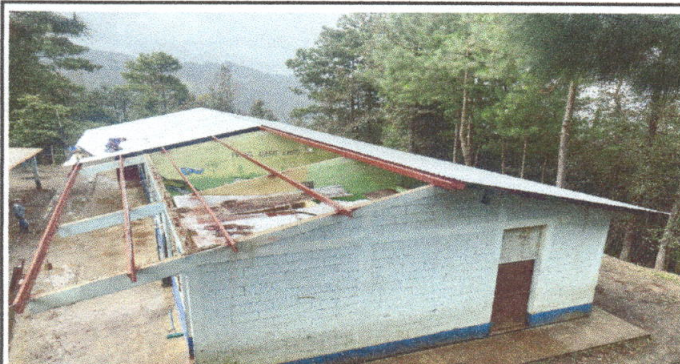
Foto 3: Se observa la instalación de las laminas.
