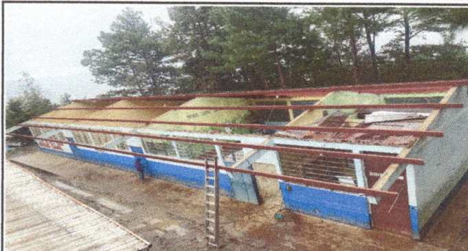
Foto 2: Se observa la lijada y la pintada de la estructura
